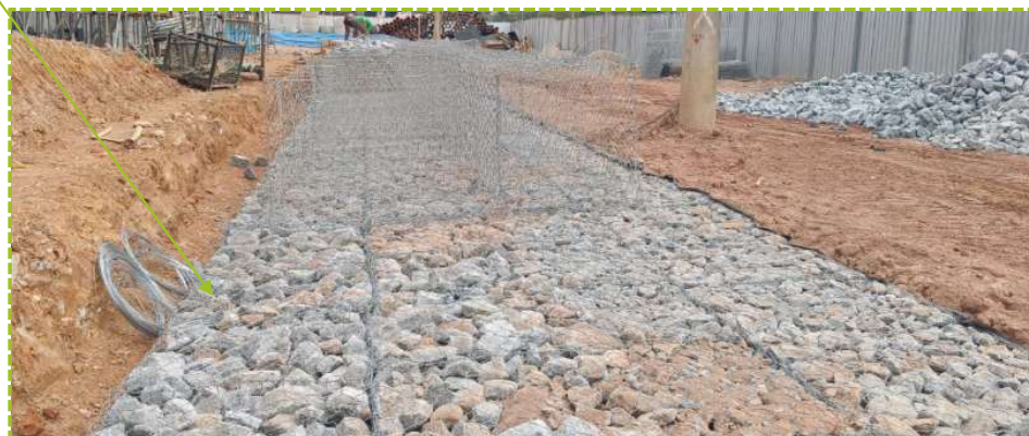
Base de gabião em caixa projeto indica BGS compactado
